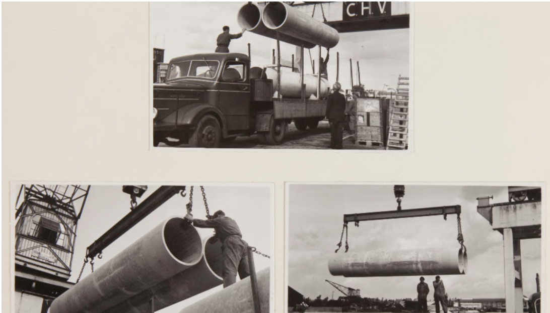
Aanleg van kunststof leidingen, Arnhem, ca. 1960 | Foto Gemeentelijk Gas-, Electriciteits- en Waterbedrijf Arnhem/Gelders Archief
